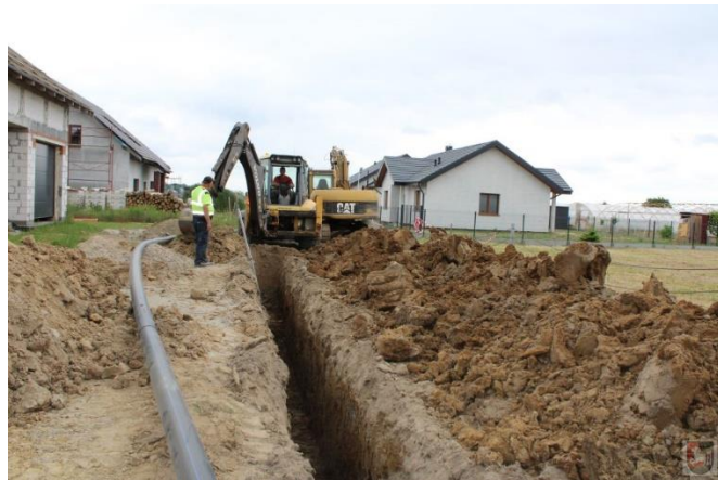
5. Modernizacja drogi gminnej - sołectwo Czechnów
